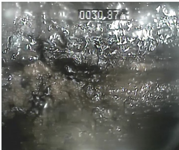
FOTO 05 - 30,87 metros, final de revestimento.
